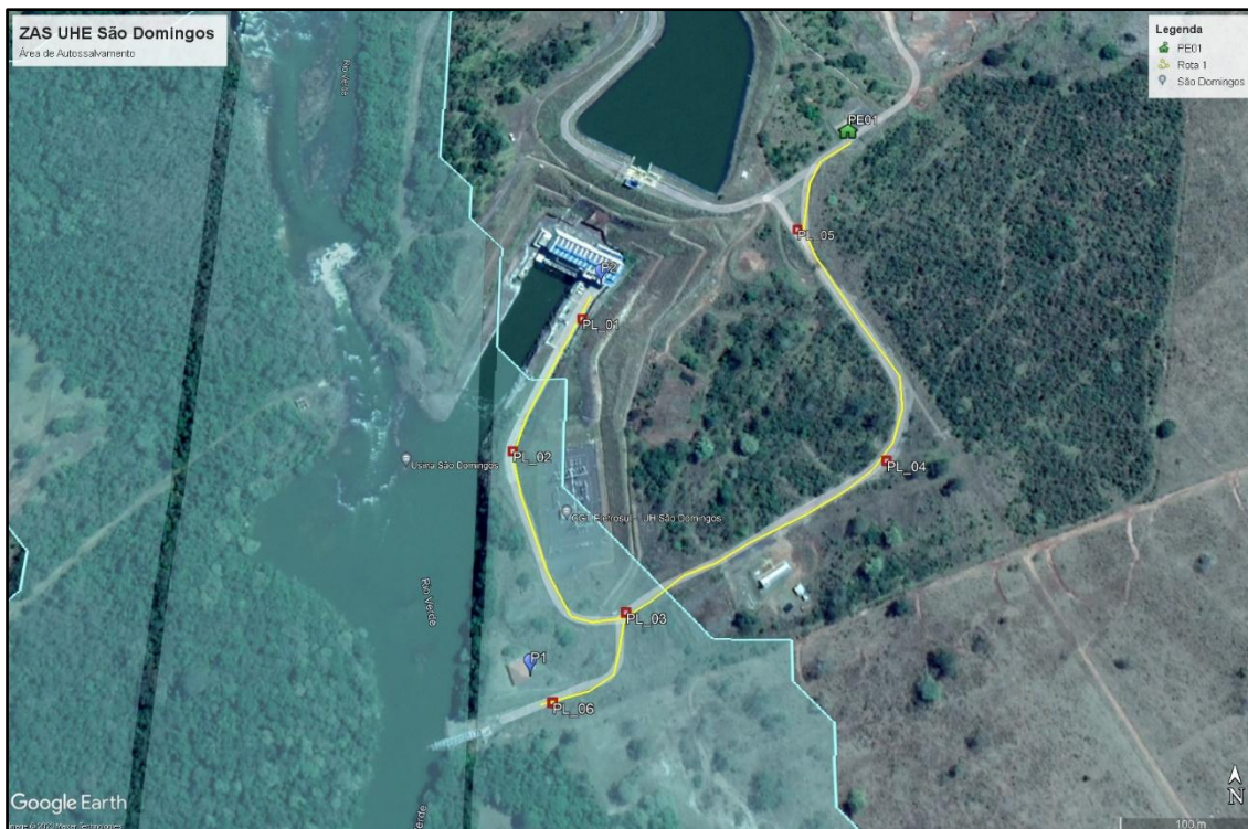
Imagem 7 - Placas Rota de Fuga 1
