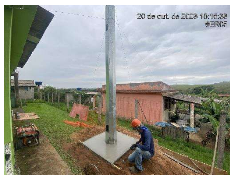
Figura 6 –Concretagem de fundação de Estação Remota.
